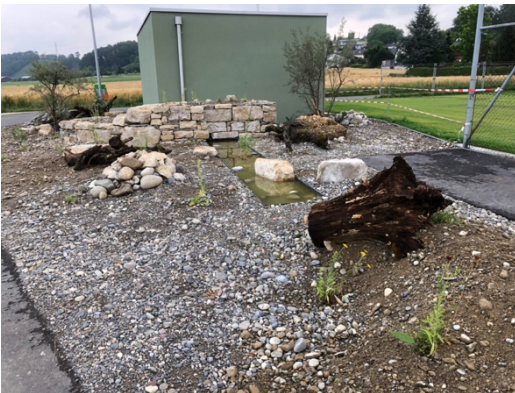
Umgebungsgestaltung Pumpenhaus Käppeli
